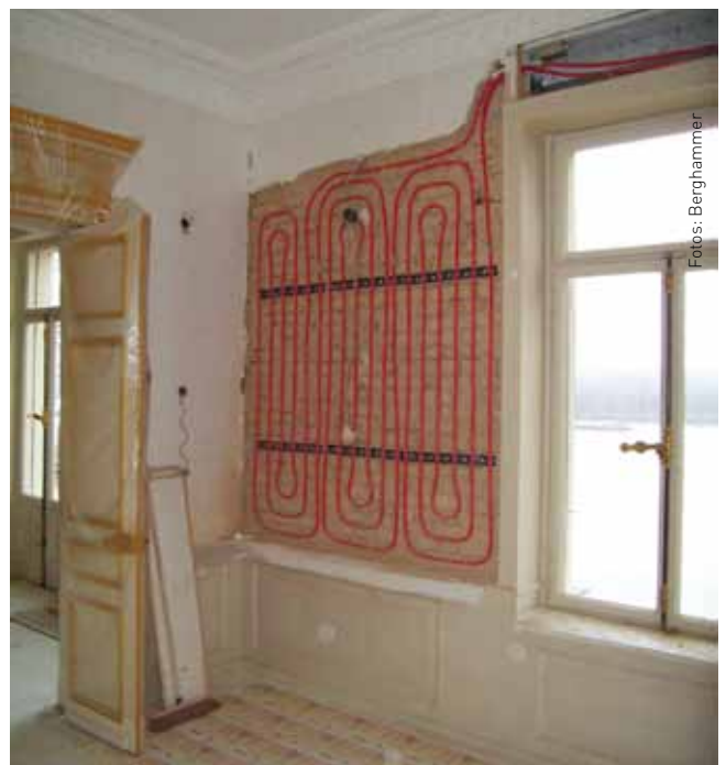
Die flexiblen Heizschlangen lassen sich entsprechend den Anforderungen verlegen.
